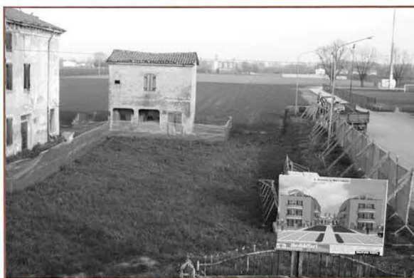
S. Antonio: avvio di nuova edificazione
