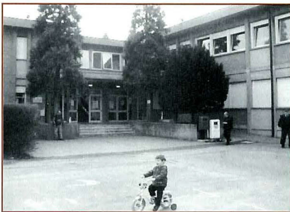
Novi- Scuola Elementare
