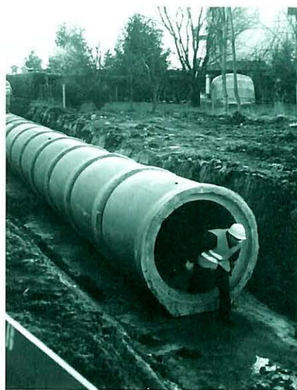
Tombamento del canale di Rovereto su cui verrà realizzata la pista ciclabile
