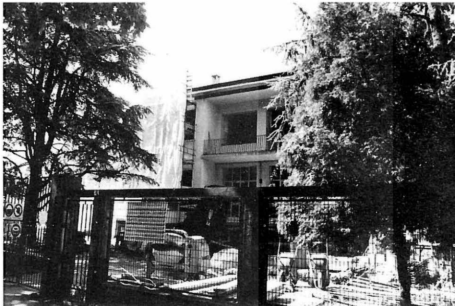
Fase della ristrutturazione della Scuola Media di Novi.
