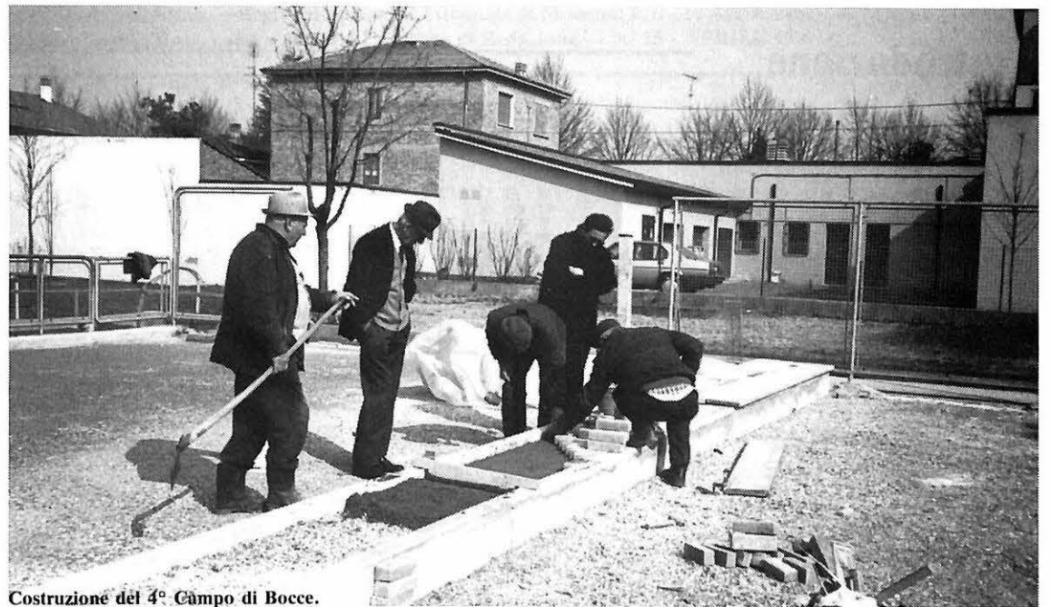
Costruzione del 4° Campo di Bocce.
