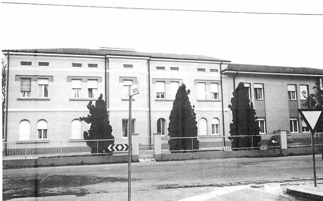
Casa di Riposo 'R. Rossi' dopo la ristrutturazione.
