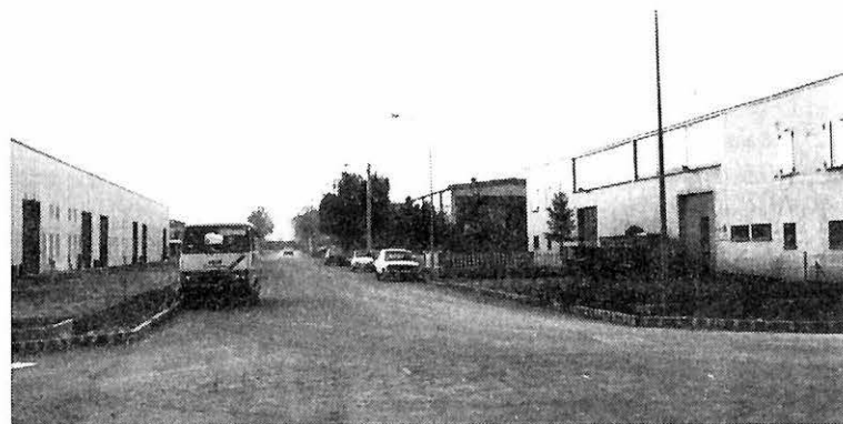
Via Torino. Zona Industriale.
